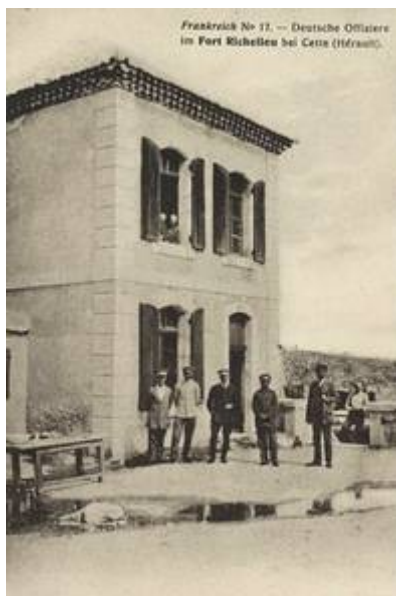
Le fort Richelieu à Cette en 1915, quelques officiers allemands posent pour le photographe. Collection J.-L. Secondy
